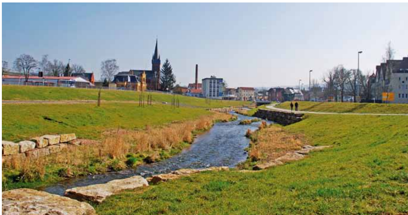
Das Geisbett liegt unter dem umgebenden Geländeneiveau – dadurch entsteht neuer Retentionsraum. Foto: WAGU
